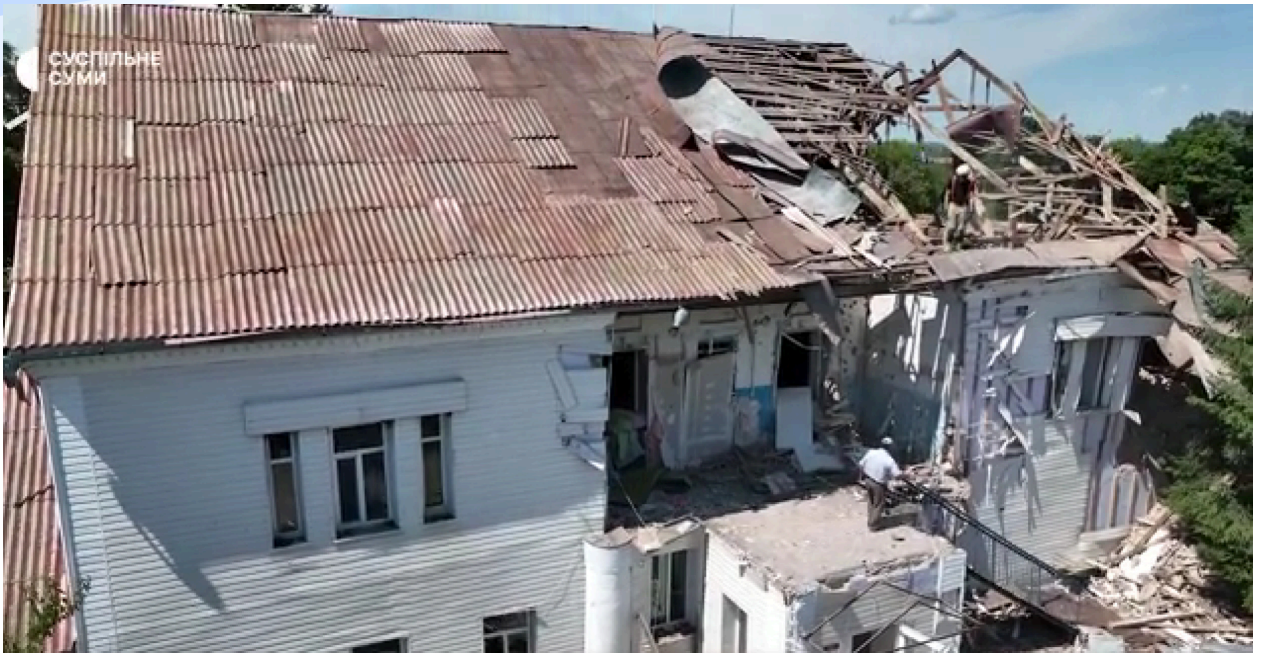
Наслідки обстрілів Атинського ПНІ. Фото з каналу Суспільне. Суми
